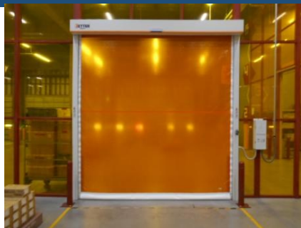
シートシャッター（前室）
